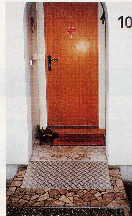
Beim Eingang wurden der Tritt und die Schwelle mit Keilen überbrückt. Die Schwelle vom Entrée ins Wohnzimmer wurde abgespitzt und die Türe mit einer senkbaren Dichtung versehen. Treppen sind schwer überwindbare Hindernisse, oft ist ein beidseitig montierter Handlauf hilfreich, oder es muss ein Treppenlift installiert werden.
