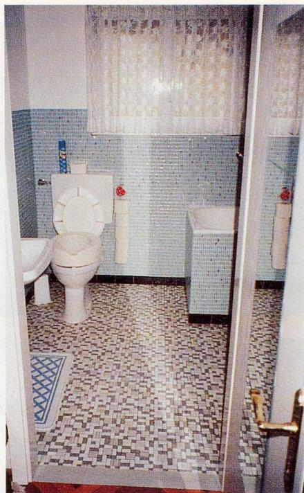
Die Badezimmertüre wurde auf 75 cm verbreitert und sie geht neu nach aussen auf. Das Kästchen unter dem Lavabo kam weg, damit es mit dem Rollstuhl unterfahrbar wird. Die Höhe der Toilettensitzfläche soll derjenigen des Rollstuhls entsprechen. Hilfreich sind fest montierte Haltegriffe neben dem Kloschett oder bei der Badewannene.
