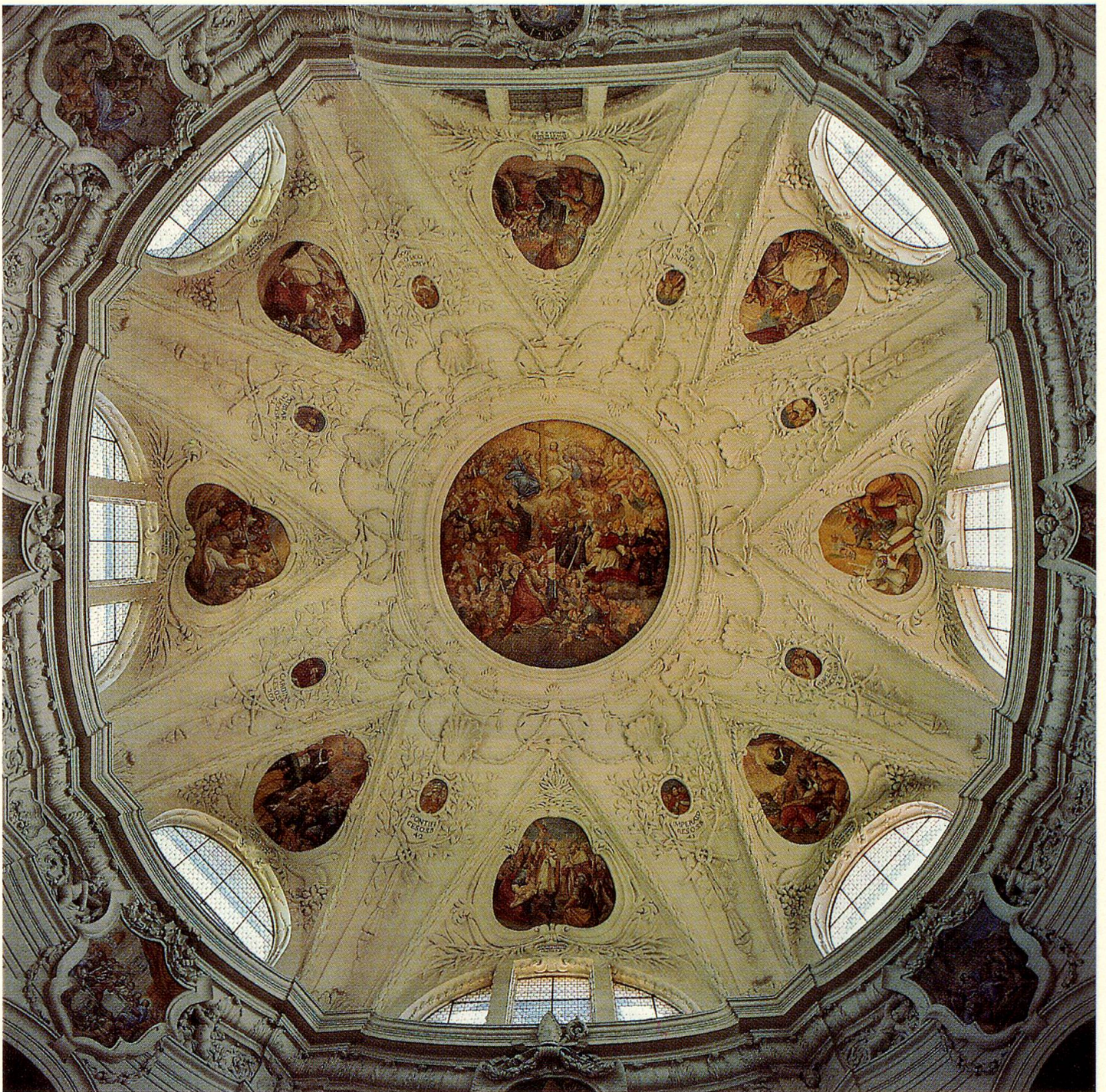
Im Zuge der Gegenreformation wurde das schlichte Langhaus durch diese prunkvolle achteckige Kuppeldecke ersetzt.
