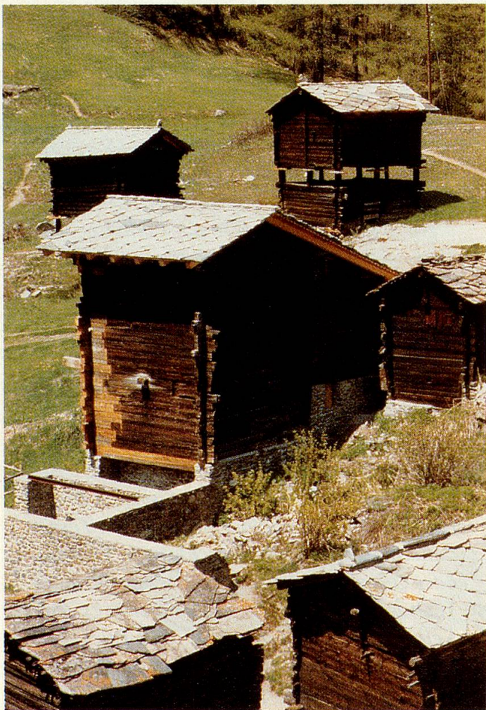
In diesem wieder instandgestellten Haus auf Zmut lebte früher die Familie Inderbinen im Sommer.
