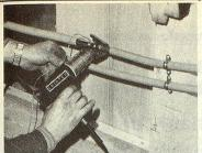
Löten einer Kupferrohr-Warmwasserleitung ohne Brandgefahr für Holz, Kabel und Kunststoffleitungen
