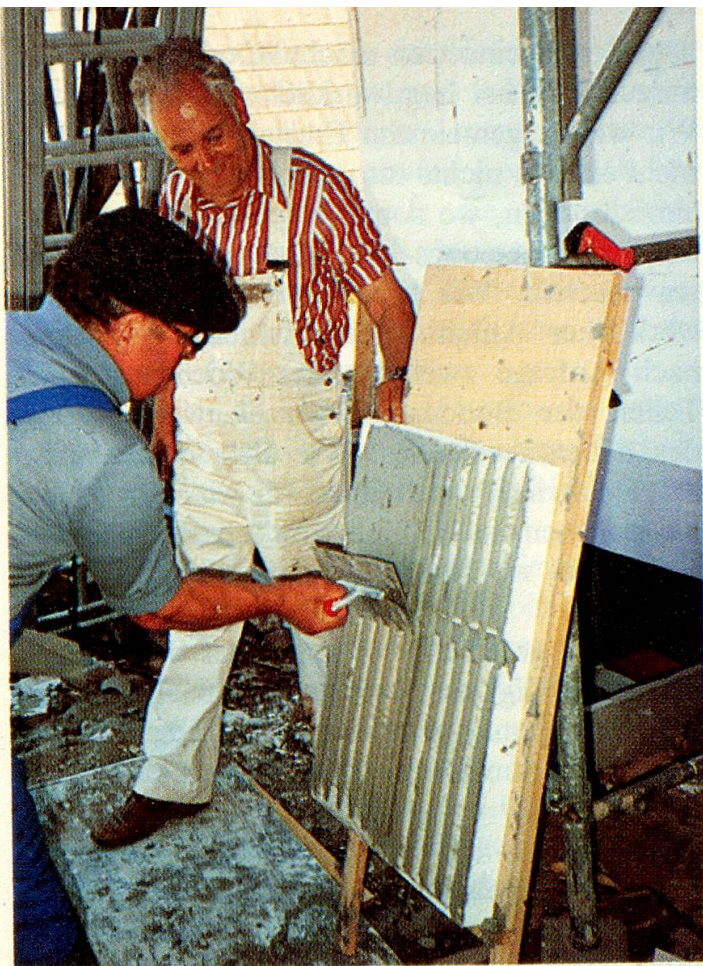
Auftragen der Klebmasse auf die Isolierplatten.
