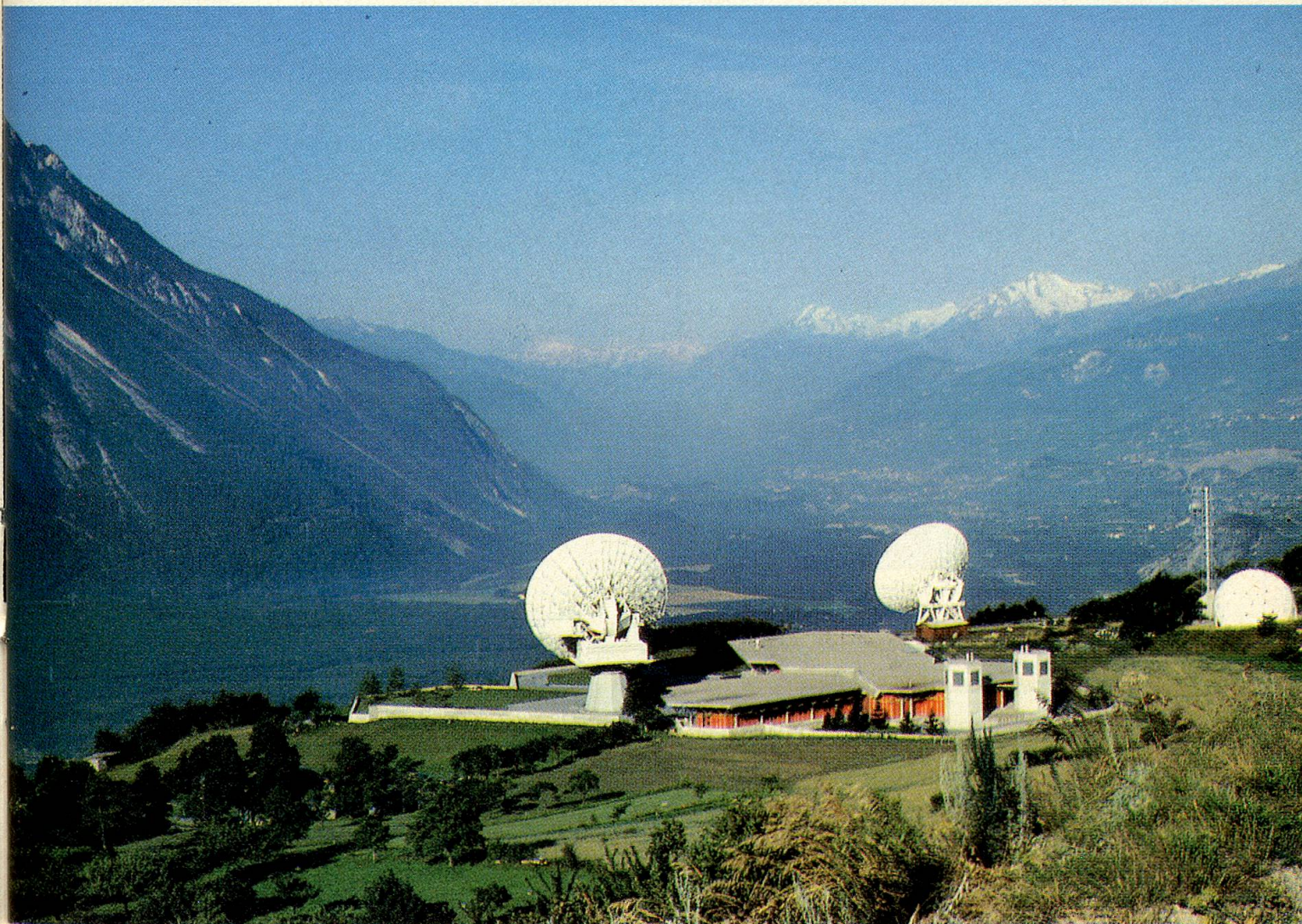
Die Bodenstation Leuk stellt die Verbindung zwischen Satelliten und bestehendem Kabelnetz her.
