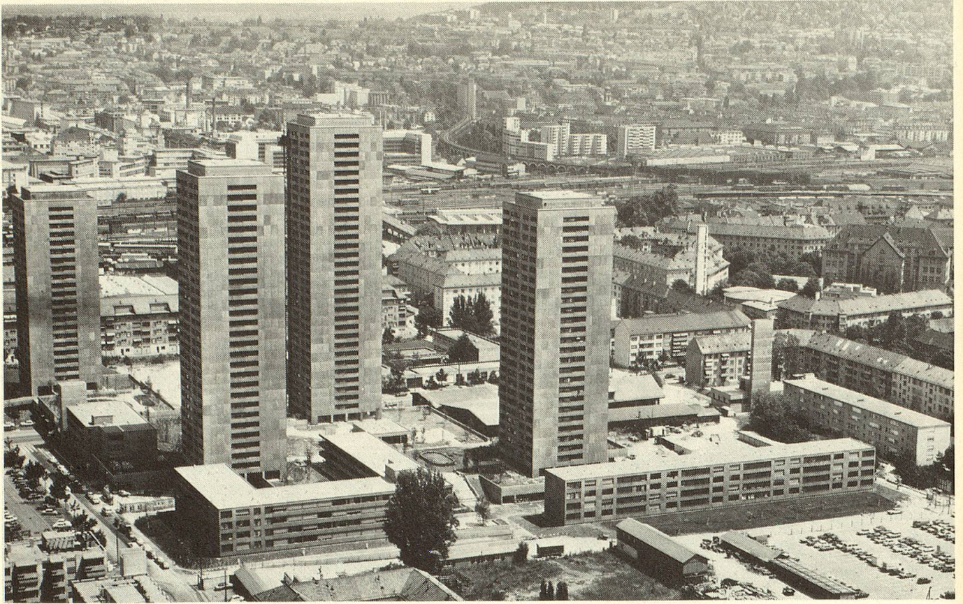
Links vor den Türmen das Hufeisen der Alterssiedlung an der Norastrasse, rechts und quer dazu Wohnungen für Familien mit Kindern. Eine Treppe führt zur Fussgängerebene. Der Wohnturm links befindet sich schon über der Bullingerstrasse, über die eine Brücke führt. Foto Comet
