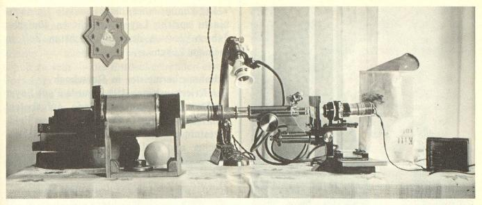
Die von Paul Layer selbst zusammengebaute Mikrofotoapparatur.
