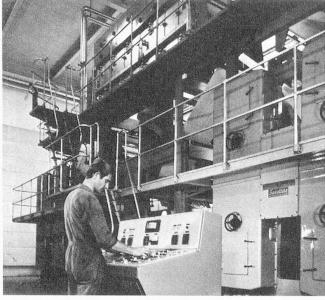
Fast so gross wie ein Einfamilienhaus ist diese Offset-Rotationsmaschine in Köniz. Sie spuckt pro Minute 150 Bogen aus und kostet die Kleinigkeit von etwa 2 Millionen Franken.
