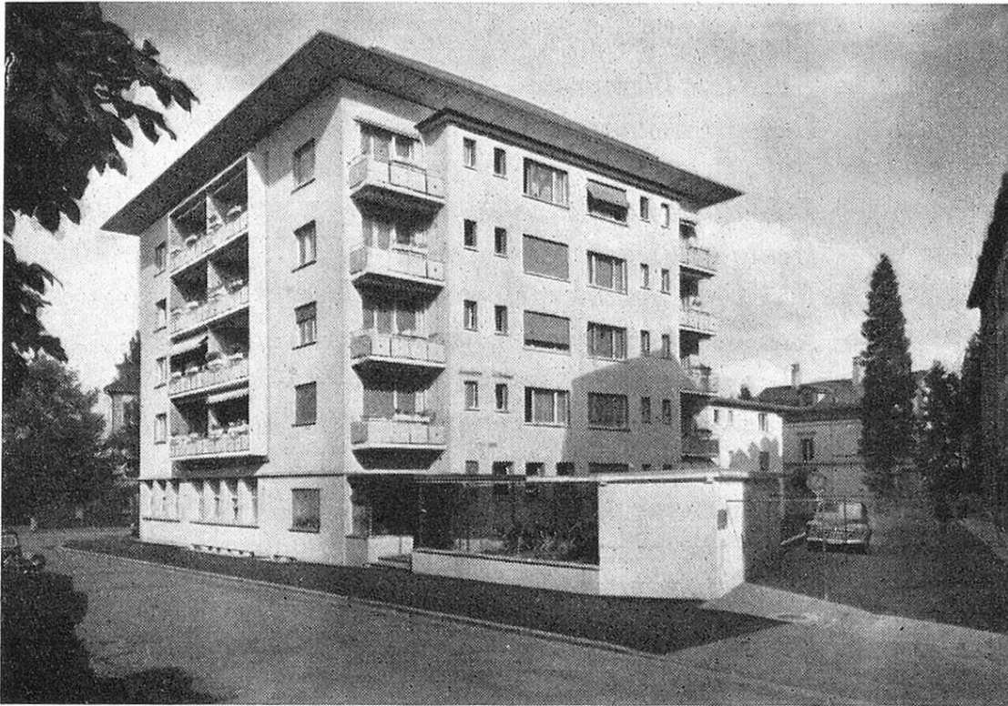
Ansicht von der Hallerstrasse aus
