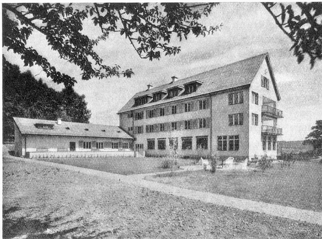
Emilienheim für alte Blinde in Kilchberg b. Zürich: Gesamtansicht. Foyer pour vieillards aveugles à Kilchberg p. Zurich: vue générale.
