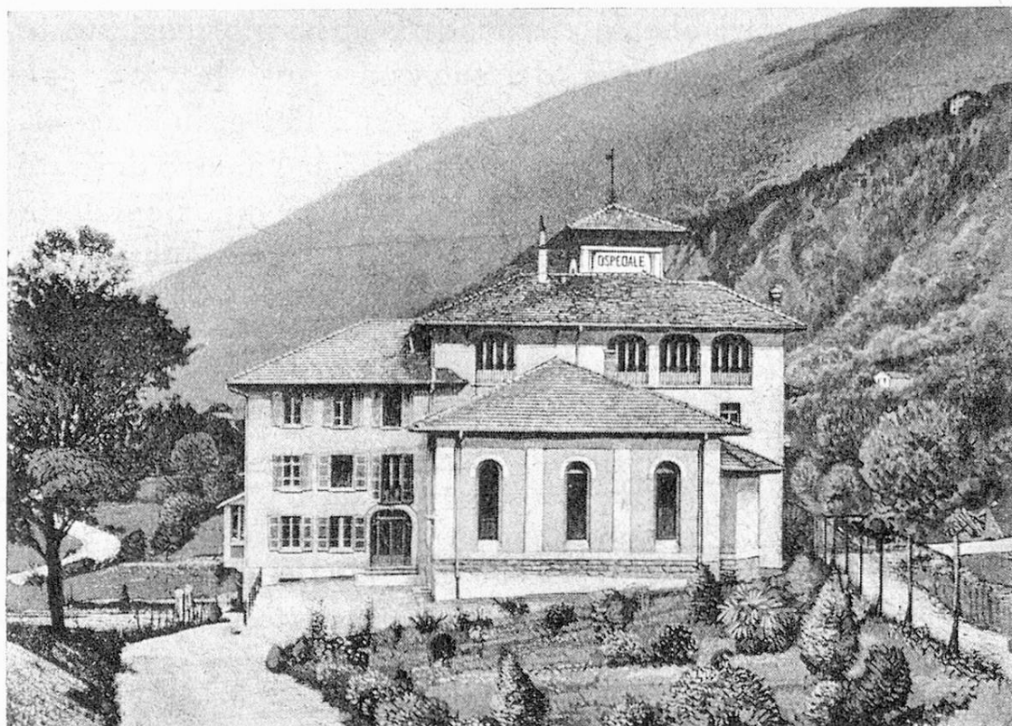
Ospedale Ricovero Bleniese Acquarossa. Alters- und Krankenhaus des Bleniotales in Acquarossa.
