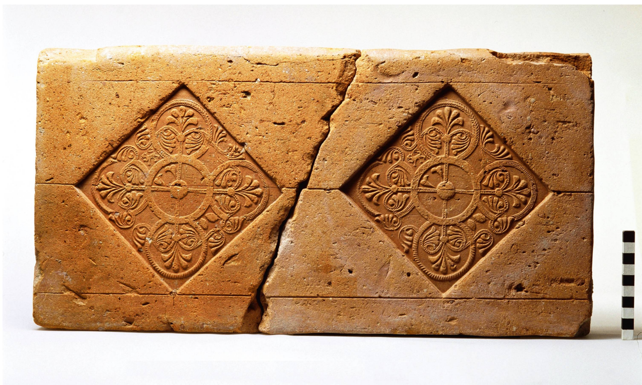
Abb. 8 Melchnau, Grünenberg. Ritzlinien auf dem als Stufe gedeuteten Backstein dienten als Anhaltspunkte für die Platzierung des Models. Formtyp 19, Fnr. 45263-55/-56.
