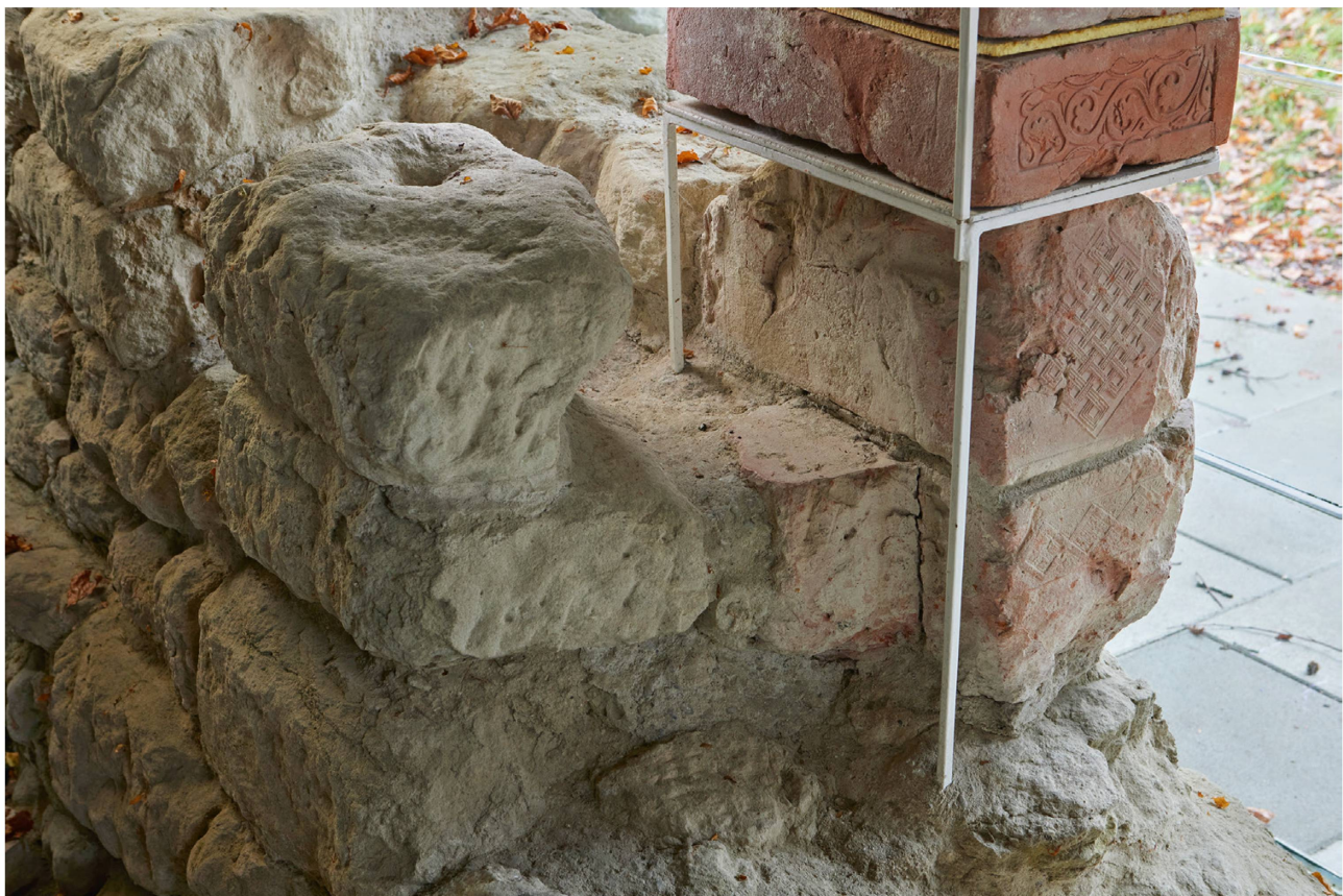
Abb. 4 Melchnau, Grüenberg. In situ erhaltene Gewändesteine an der Südseite des Kapellen- portals im Verband mit der Mauer (Formtypen 9 und 18). Blick vom Kapelleninneren gegen Westen.
