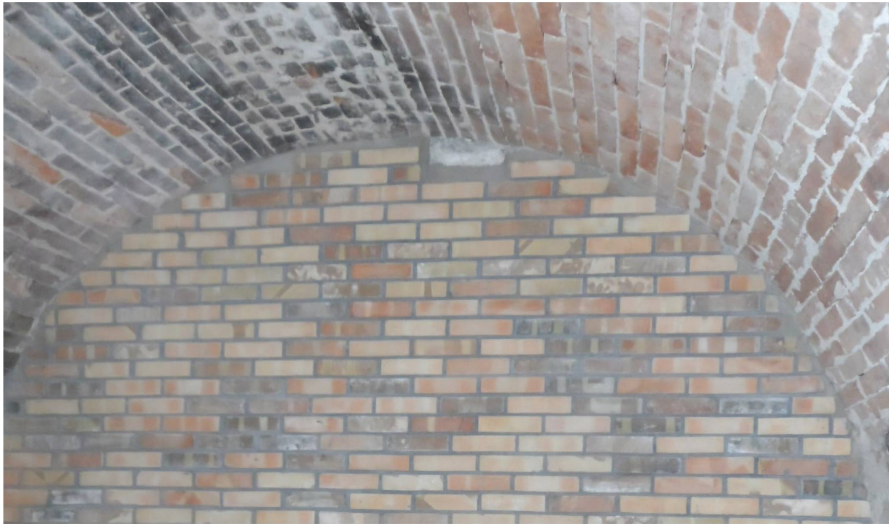
Die farblich lebendigen Backsteine aus dem Ziegelbrand 2022 im Gewölbe des Kellers von René Blum. (Foto Ziegelei-Museum)
