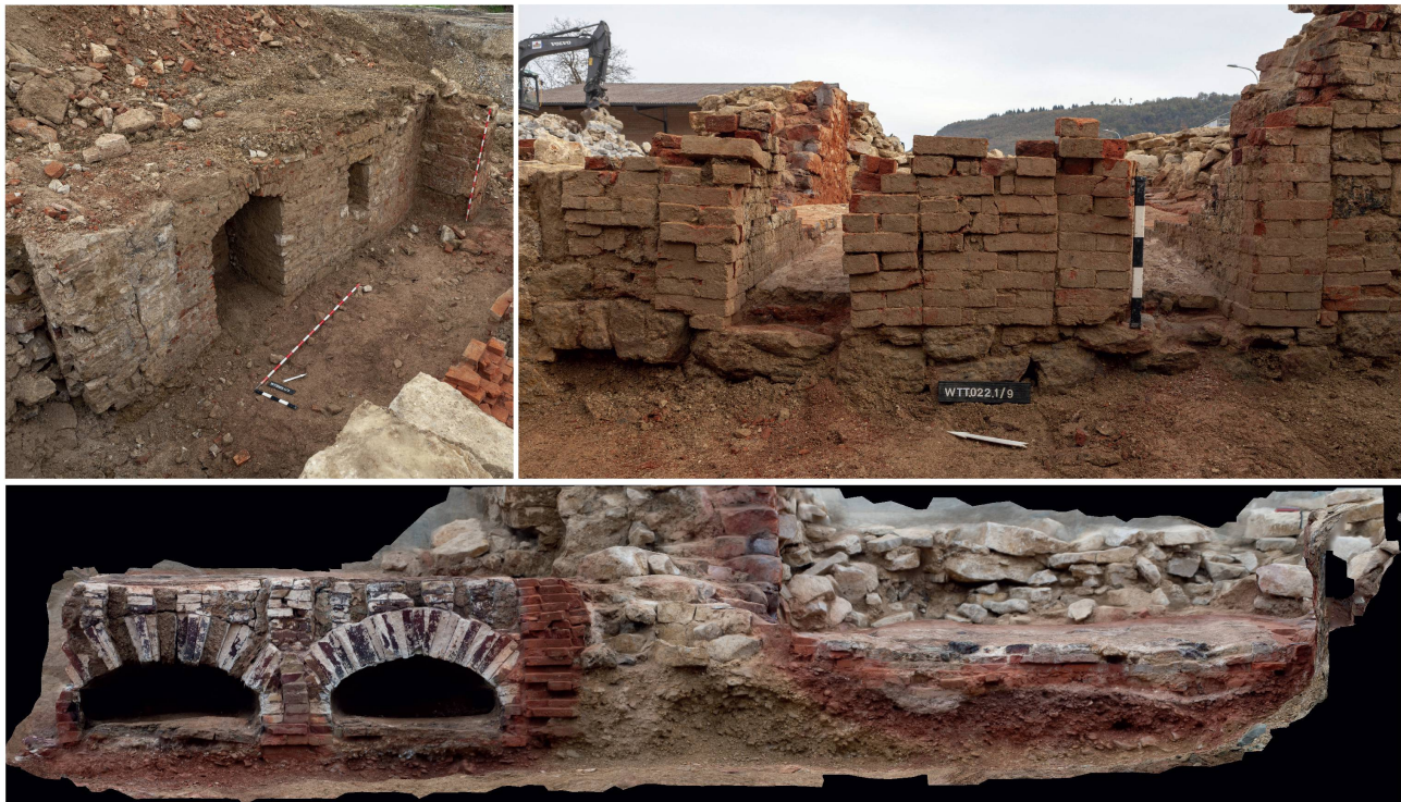
Abb. 10 Übersicht der West- und Nordwand des Arbeitsraumes mit Nische und nördlich anschliessendem Fenster-schacht.
