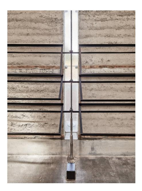
zu den filigranen Zugseilen stehen (Abb. 5). An letztere können einfache Stahlrahmen für Ausstellungspanele oder Exponate geklemmt werden. Eine Wendeltreppe aus Stahl erschliesst die Aussichtsplattform auf dem Dach (Abb. 6).
