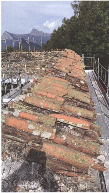
Jenins GR, Burgruine Neu-Aspermont. Abdeckung der Mauerkronen mit spätmittelalterlichen Hohlziegeln.
