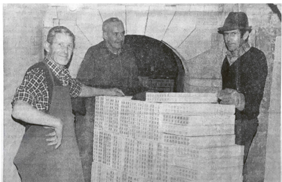
Die letzten Backsteine verlassen den Ofen der Ziegelei Ibach
