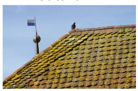
Abb. 4 Luzern, Kapellbrücke. Einfachdeckung sowie Firstund Gratkrone nach der Renovation 1994. Foto Jürg Goll, 2021.
