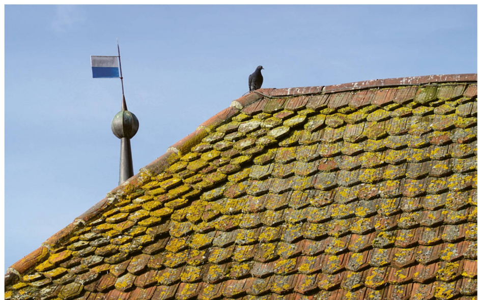
Abb. 4 Luzern, Kapellbrücke. Einfachdeckung sowie First- und Gratkrone nach der Renovation 1994. Foto Jürg Goll, 2021.
