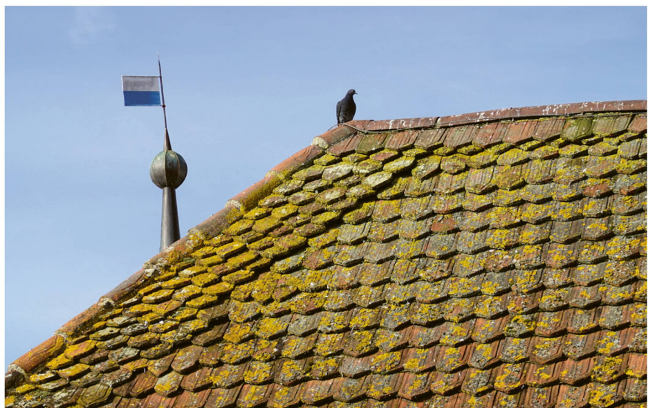
Abb. 4 Luzern, Kapellbrücke. Einfachdeckung sowie First- und Gratkronen nach der Renovation 1994. Foto Jürg Goll, 2021.
