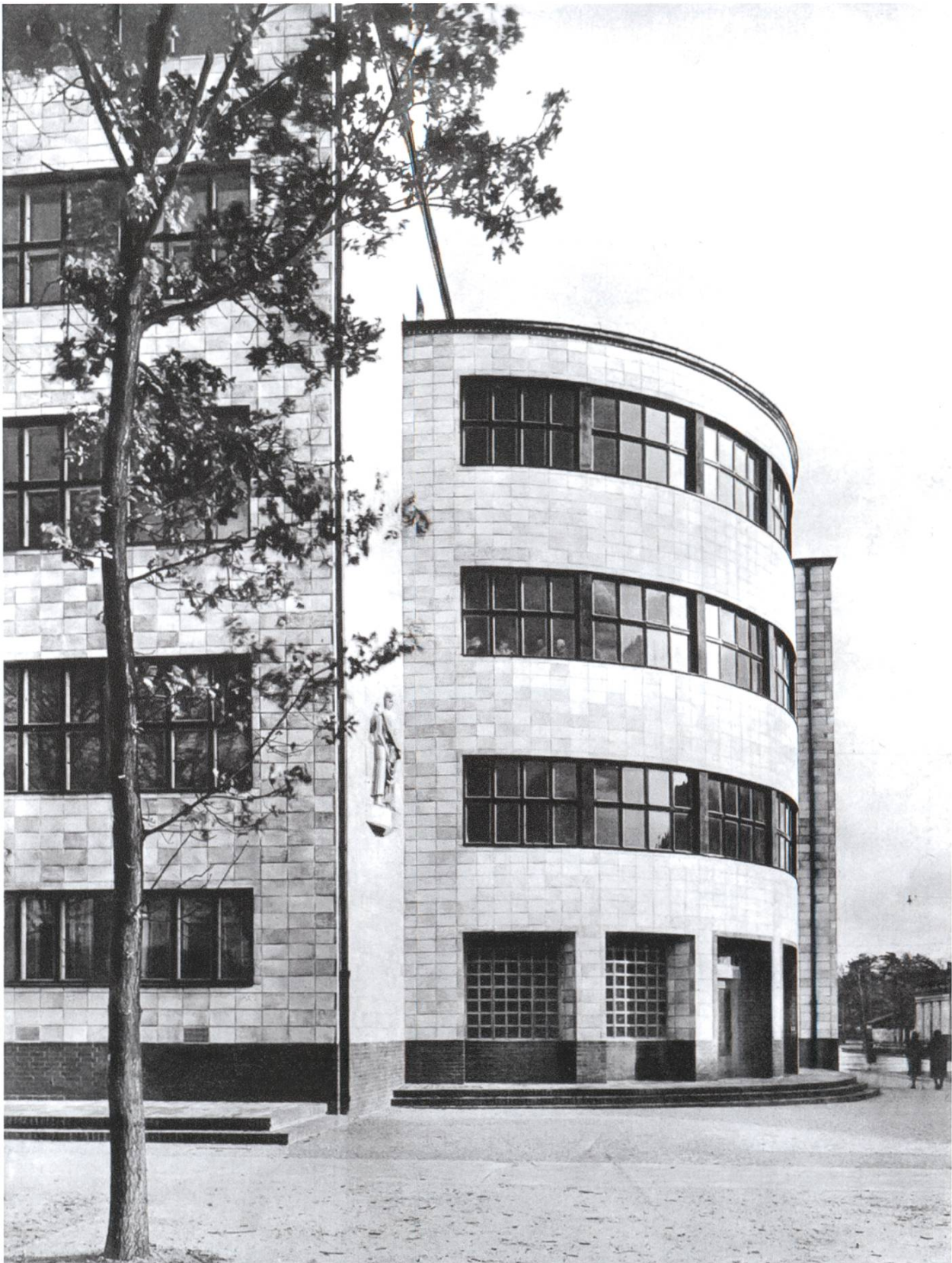
Ehemalige Dorotheenschule, Architekt Max Taut 1928/1929 (historische Aufnahme von 1931). Beispiel für eine vollflächige keramische Verkleidung im Raster mit nur einem standardisierten Format. Viele der funktionellen Eigenschaften des Gebäudes, vor allem auch seine besondere gestalterische Wirkung, werden durch die keramische Verkleidung erreicht. Sie ist zwar nicht mehr erhalten – ihre Rekonstruktion jedoch geplant.
