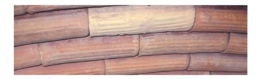
schicht Ziegel hergestellt, die die Höhe der Humusüberdeckung aufnimmt und durch einen Mörtelkeil zur Oberkante des Gewölbes vermittelt. Der Bereich unter dem gemauerten Bogen ist ausgemauert und mit Fenster- und Türöffnungen versehen worden. Die Stirnseiten sind verputzt.
