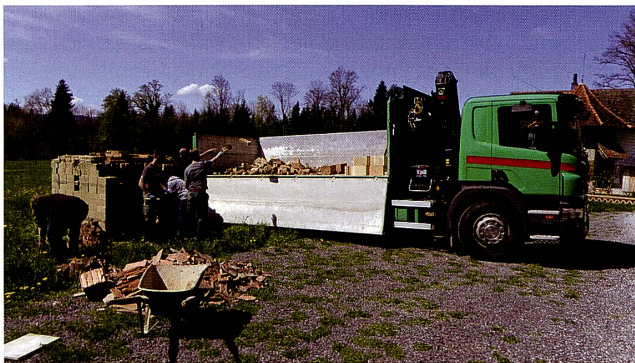
Aufräumaktion. Auch die überschüssigen Backsteine des Feldbrandofens werden mit Unterstützung des Gönners Hans Gyr abgeführt.
