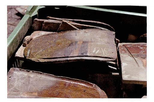
Abb. 3 Glurns, Ziegellagerung während der Umdeckung. Glurns Typ 1.
