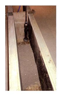
Abb. 9 Schalungselement für die Herstellung von Stampflehmwänden.
