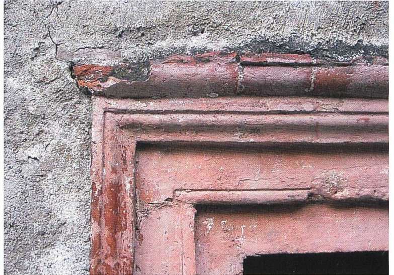
Barockes Fenstergewände aus Terrakotta in Bormio (Veltlin, Italien).
