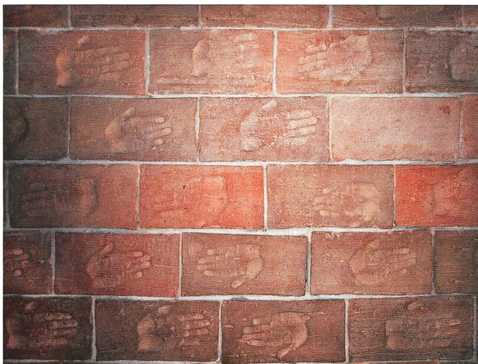
Händlistensteinwand in Kyburg Haus an der Hinterdorfstrasse 35, küchenseitige Wand zwischen Gang und Küche im Erdgeschoss, gangseitig mit verputztem Rutengeflecht. Baujahr nicht genau bekannt, vermutlich 18. Jahrhundert.
