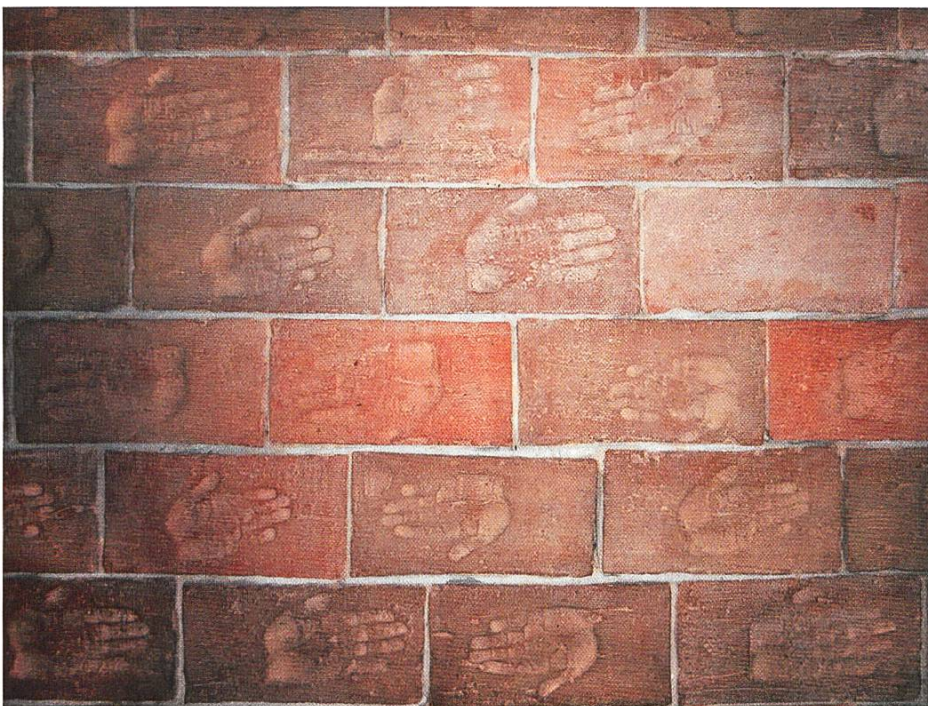
Händlisteinwand in Kyburg Haus an der Hinterdorfstrasse 35, küchenseitige Wand zwischen Gang und Küche im Erdgeschoss, gangseitig mit verputztem Rutengeflecht. Baujahr nicht genau bekannt, vermutlich 18. Jahrhundert.
