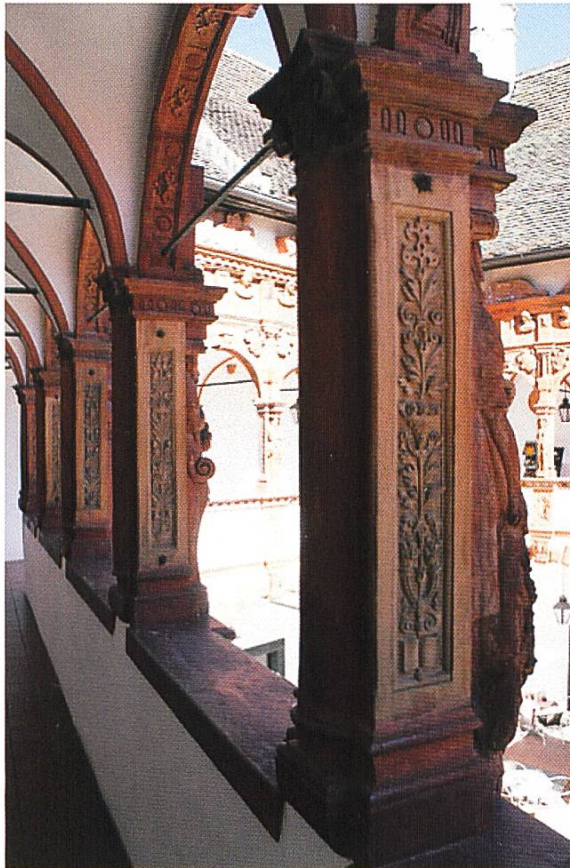
Abb. 6: Schallaburg, Arkadenhof, unterschiedliche Materialien im heutigen Bestand: 6a: Herme, Originalterracotta 1571–1577. 6b: Dudelsackspieler, Terracotta von 1906/1908 6c: Gemauerte Säulen mit Seitenwangen aus Gips von 1906. 6d: Kunststeinguss von 1973.
