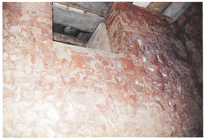
Abb. 8: Cham, Ziegelhütte, Ofeninneres mit erhaltenem Ofenmantel darin die südliche, obere Sandtüre, gegen Süden; Foto von Benedikt Frei, September 1968.
