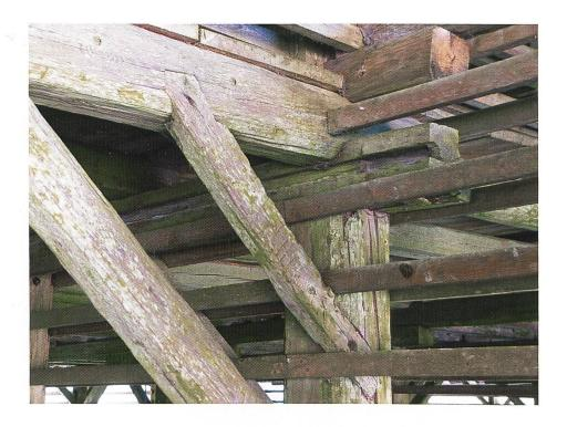
tragen. Deren Auflagestellen sind durch Sattelhölzer verstärkt, unter denen Schrägstreben zu den Pfosten hin die nötige Versteifung herstellen. Über dem Obergeschoss liegen in der Flucht der Unterzüge die Fusspfetten der beiden Dachstühle.
