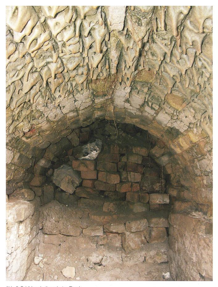
Abb. 5: Schürkanal mit verglasten Ziegeln.
