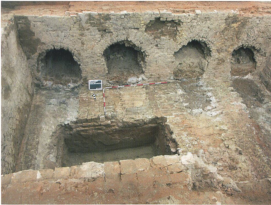
Abb. 4: Nordmauer des Ziegelofens mit vier Schürlöchern.
