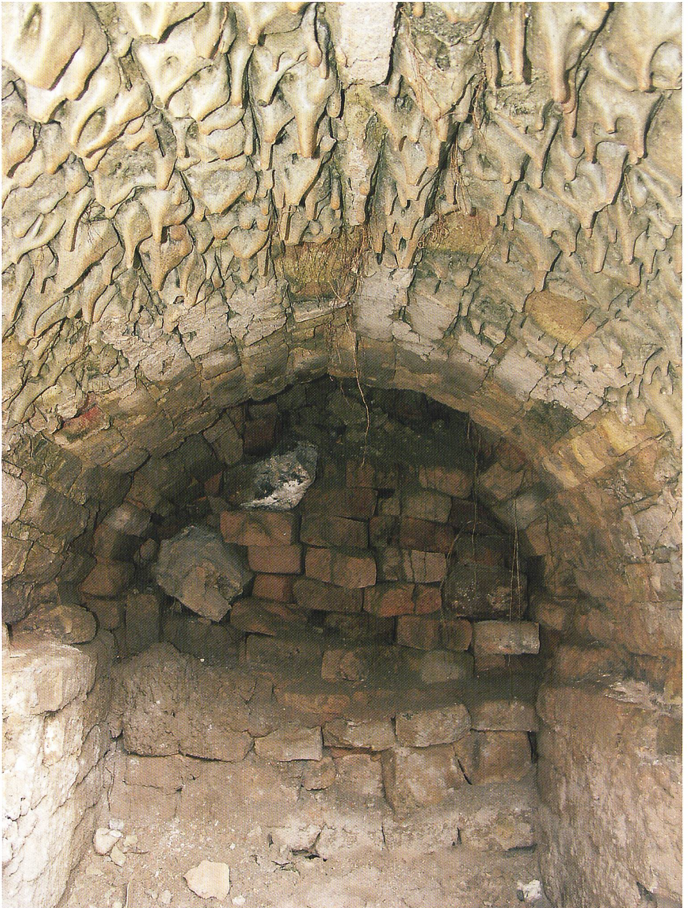
Abb. 5: Schürkanal mit verglasten Ziegeln.
