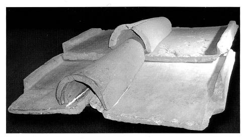
Abb. 5 Römische Leistenziegeldeckung mit tegula und imbrex.
