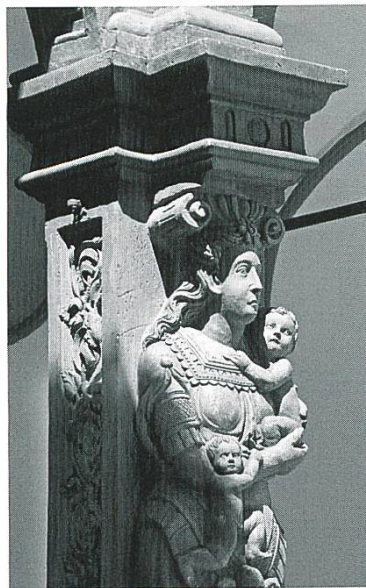
Bauterrakotta: links Arkaden- hof der Schallaburg in Niederösterreich, rechts Ausschnitte aus einem Prospekt der Firma Bodmer in Zürich.
