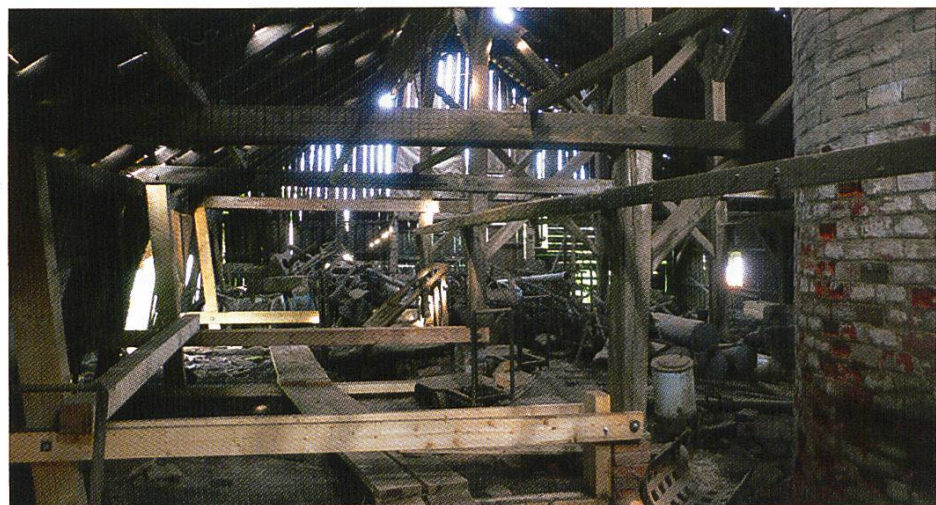
Leoben in der Obersteiermark A, ehemalige Ziegelei Dörfler: Raum mit Gerätschaften über dem Ringofen.
