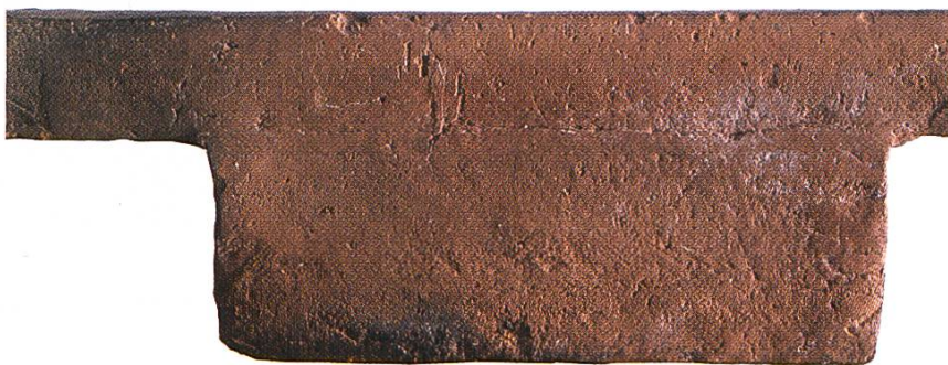
Abb. 15 Hirsau, St. Aurelius. Detail der Nase mit geglättetem Grat an der Naht zwischen Ziegelplatte und der Leistennase.
