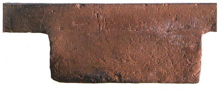
Abb. 15 Hirsau, St. Aurelius. Detail der Nase mit geglättetem Grat an der Naht zwischen Ziegelplatte und der Leistennase.
