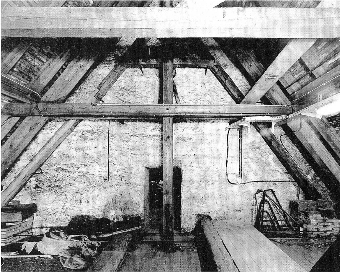
Abb. 6 Reichenau- Mittelzell, Klosterkirche St. Maria und St. Markus, Südgiebel des östlichen Querhauses, Ansicht von Norden.
