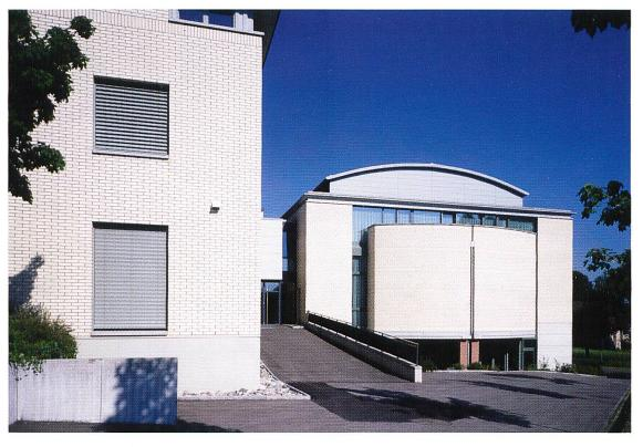
Abb.5 Kleinformatige weisse Sichtsteine lassen die Fassaden dieses Gemeindezentrums wie ein feingestricktes Muster erscheinen, das durch Bänder von in senkrechter Position vermauerten Sichtsteinen (Rollschichten) unterbrochen wird.
