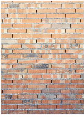
Abb. 11 Als Kontrast zu den weit verbreiteten unifarbigen Bauten werden heute auch wieder vermehrt alte Mauerwerksbilder mit Kohlebrandeffekten gesucht. Die Backsteine für die hier abgebildete Wand wurden nach einem speziellen Verfahren in einem modernen Ziegelofen
