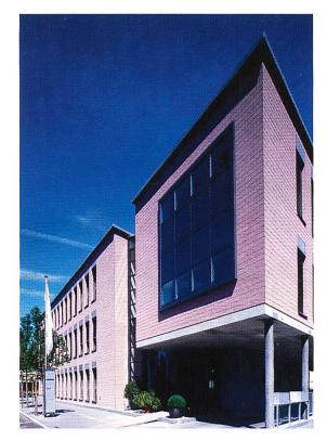
Abb. 8 Moderner Sichtsteinbau aus platinfarbigen Sichtsteinen mit granulierter Oberfläche.
