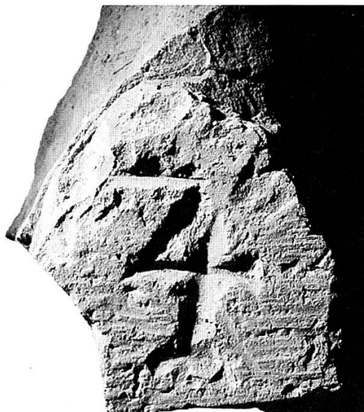
Abb. 6 Werkstück mit ein- geritztem Versetz- zeichen; L: 27, B: 23, H: 25 cm.
