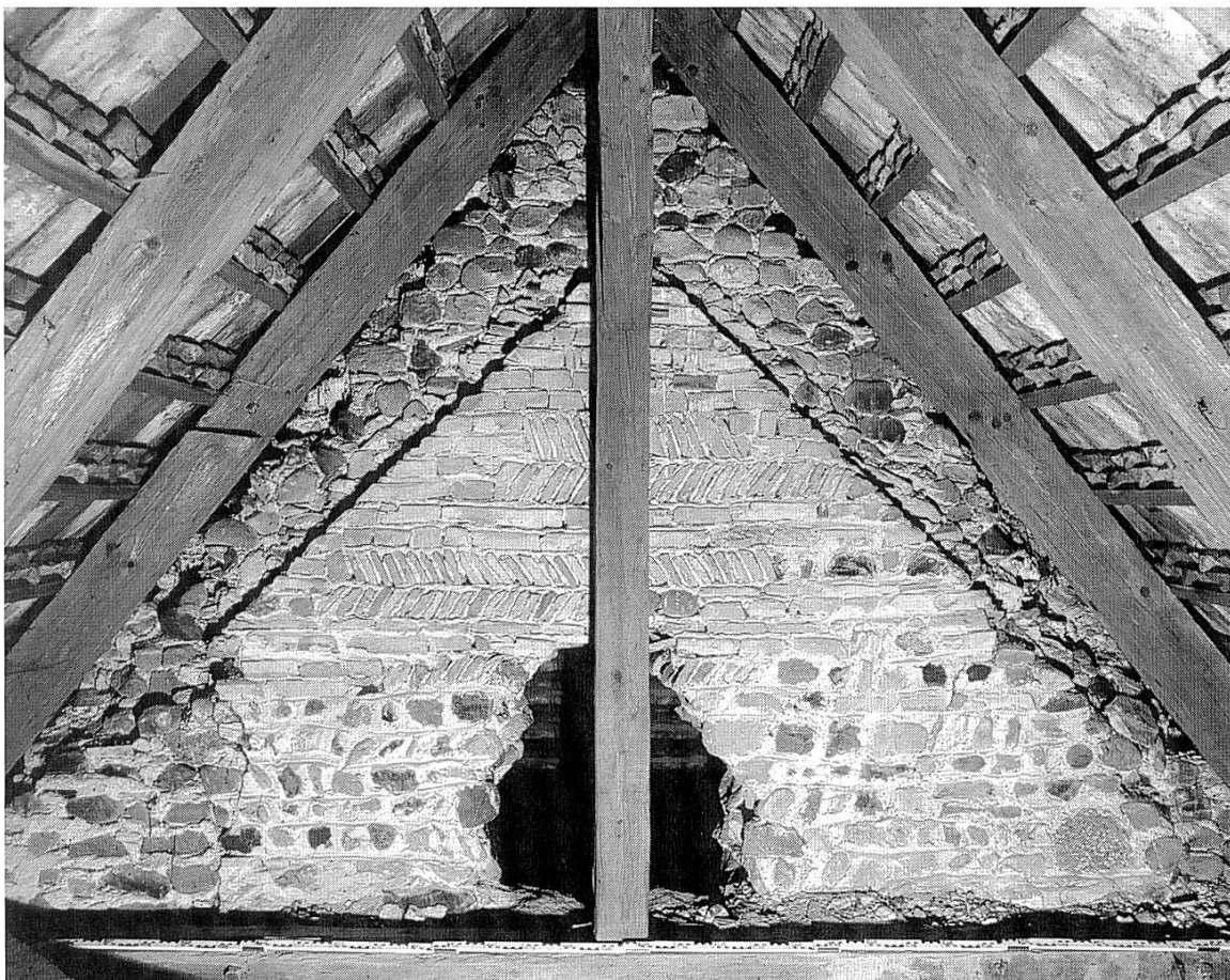
Abb. 1 Östliche Giebel- scheibe mit Ziegelfrag- menten im Dachraum des Schiffs, gegen Osten.
