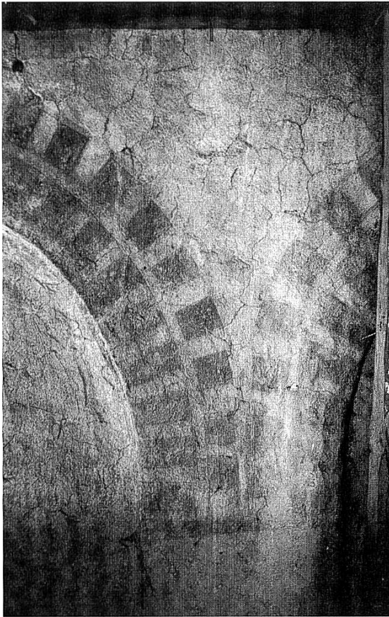
Abb. 7 Wechsel von Tuff- und Backsteinen an einer romanischen Türlaibung von Pfyn TG, 1. Hälfte 12. Jh.
