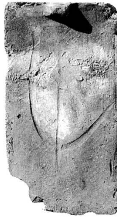
Fig. 9 Tuile à découpe droite moulée «à la française», provenant de la tour des juifs. Surface extérieure laissée brute; côté intérieur lissé montrant un signe tracé au doigt, éventuellement la «signature» du mouleur ou un repère quelconque dans la production.
