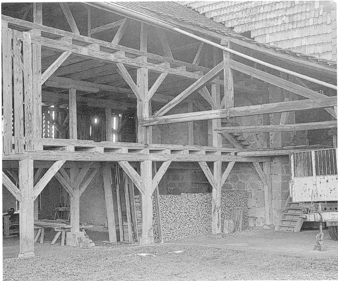
Abb. 1 a/1 b Hallau SH: Blick in die heute abge- brochene Ziegelhütte, Zustand 1991.
