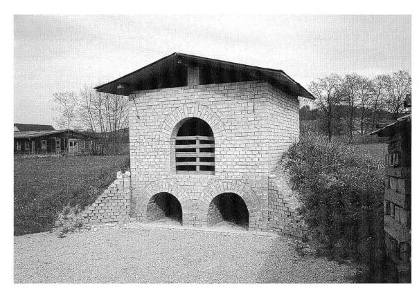
Abb.1 Ofen des Backsteinexperiments in St. Urban
