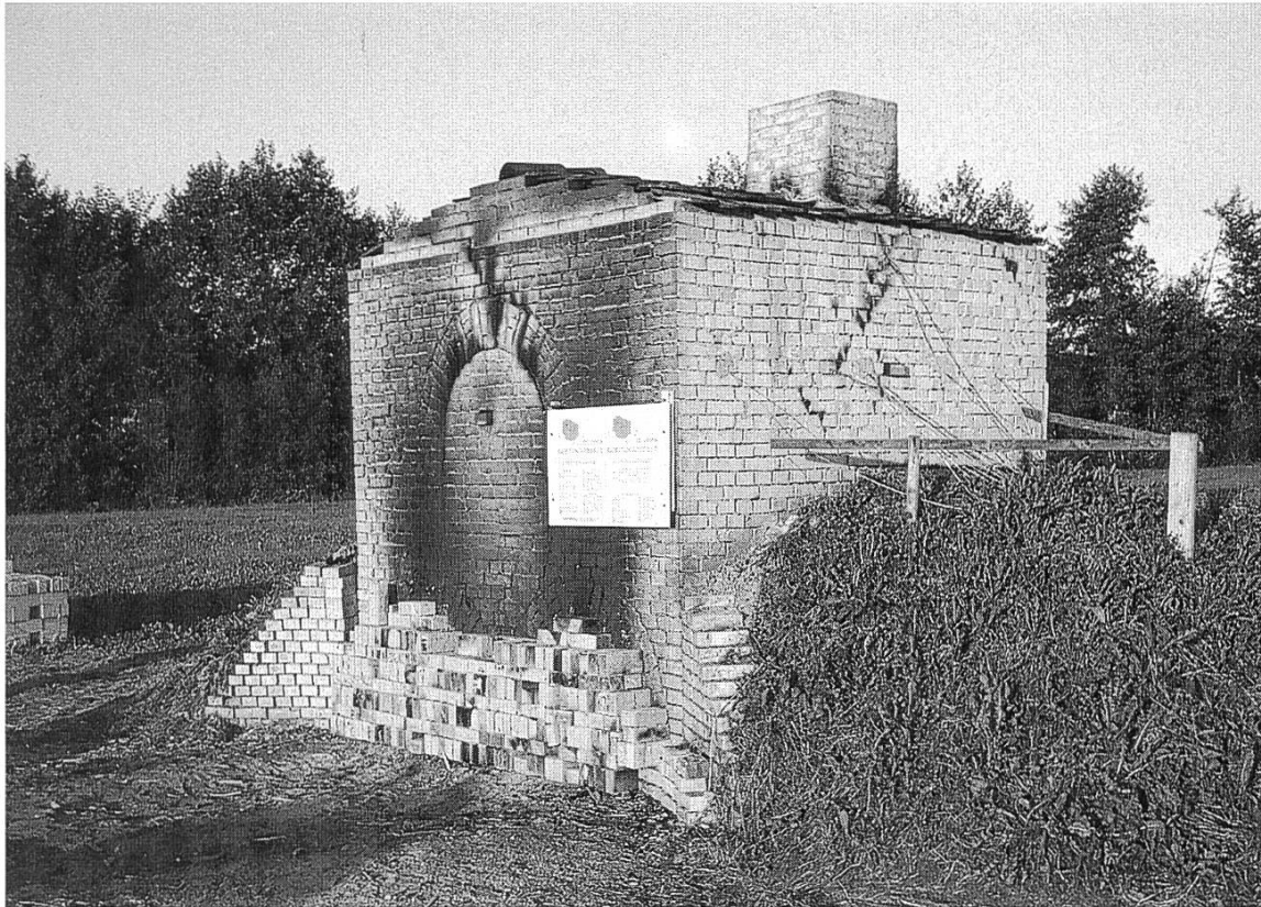
Abb.7 Ofen des Backstein- experiments in St. Urban während des Abkühlens.
