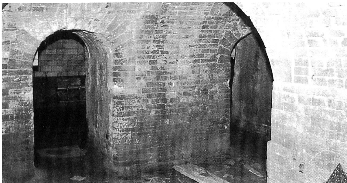
Abb.10 Zickzackofen in Muri AG, Ofeninneres und Beschickungs- türen.
