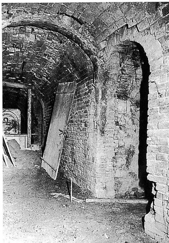
Abb. 6 Vinzel: Im Brenngang (hier im westlichen) sind nahe der Beschickungstüre noch die Lehmwulste zu sehen, mit denen die Papierschieber zwischen den einzelnen «Kammern» befestigt waren.
