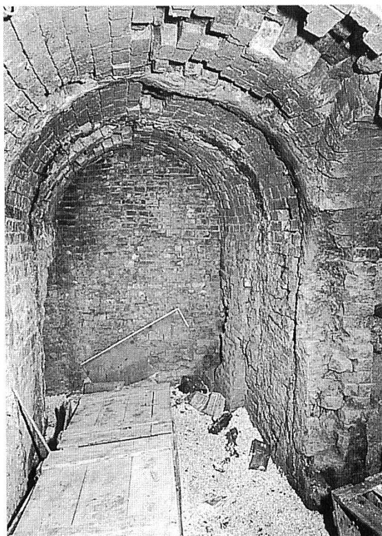
Abb. 5 Vinzel: Am Südende des westlichen Brenngangs geht der niedere Verbindungsstollen gegen links weg. Die innere Auskleidung des Brenngangs besteht aus Vollbacksteinen.
