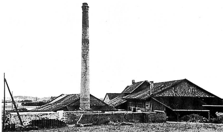
Abb. 2 Ziegelei Vinzel um 1932 von Nordosten: Der Ringofen steht im Schuppen hinter dem Kamin. Die Freiluft-trockenschuppen erkennt man im Vordergrund rechts. Unter dem erhöhten Dach dahinter befand sich der alte periodische Ofen.
