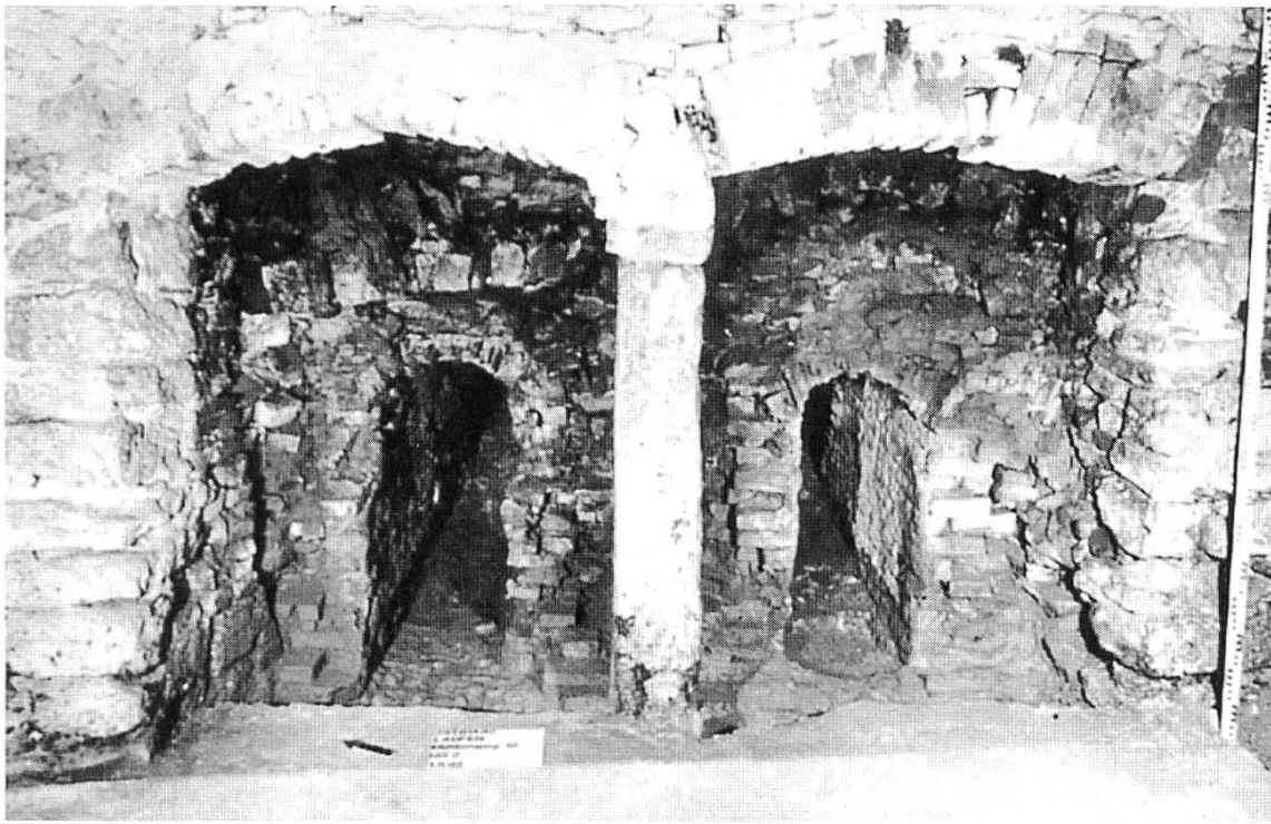
Abb. 6 Aussen- ansicht der Schürflöcher des grossen Ofens 2. Der Mittelpfosten stützt den Kaminhut des Rauch- abzuges.
