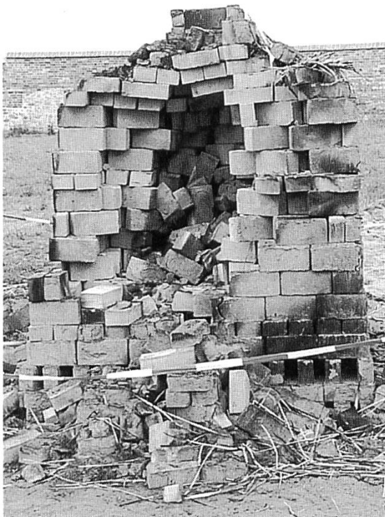
Abb. 2 Geöffneter Feldbrand- ofen.
