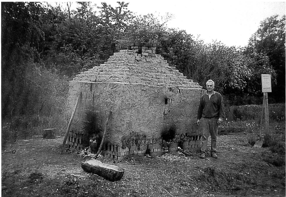
Abb. 3 Feldbrandofen in der Aufheizphase.
