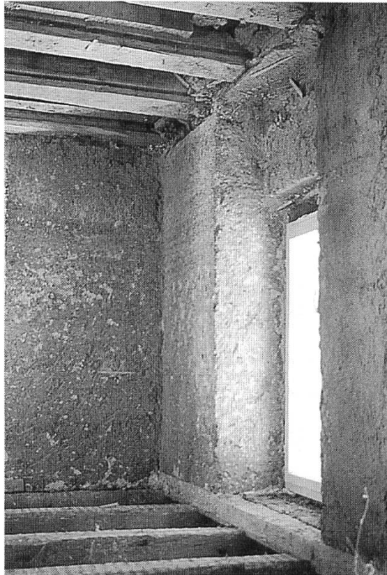
Abb. 4 Pisébau in Thundorf TG, Innenaufnahme ohne Putz während der Renovation.
