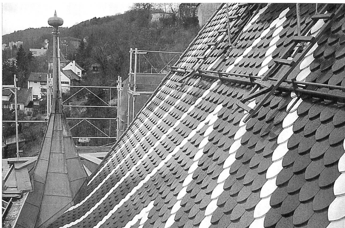
Abb. 17 Neugedeckte Dachfläche und Kupfer- helm des Erkers.
