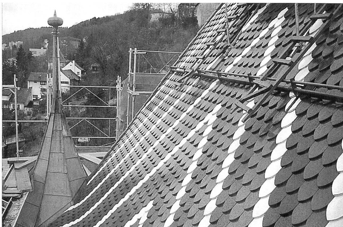
Abb. 17 Neugedeckte Dachfläche und Kupfer- helm des Erkers.
