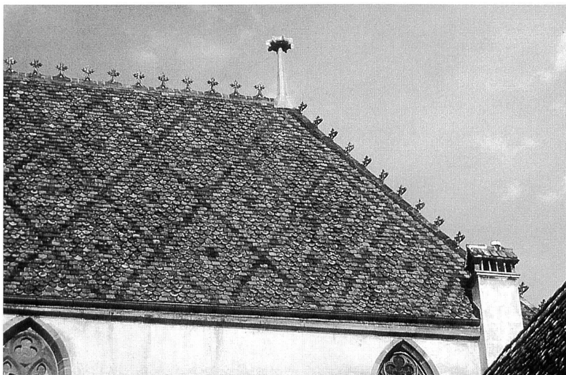
Abb. 1 Das Dach der Niklauskapelle nach der Restaurierung im November 1989. Das wiederhergestellte Rautenmuster besteht aus 85% alten und 15% neu angefertigten Ziegeln. Vollständig neu angefertigt wurden nach altem Muster die First- und Gratziegel sowie der Knauf.
