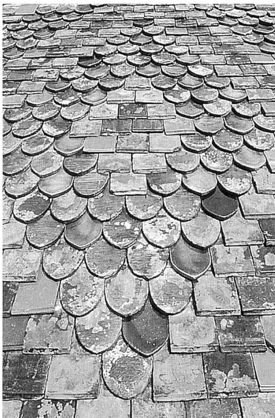
Abb. 2 Rauten- muster auf dem Dach der Niklaus- kapelle aus verschie- denen Ziegelformen und -farben (nach der Renovation).
